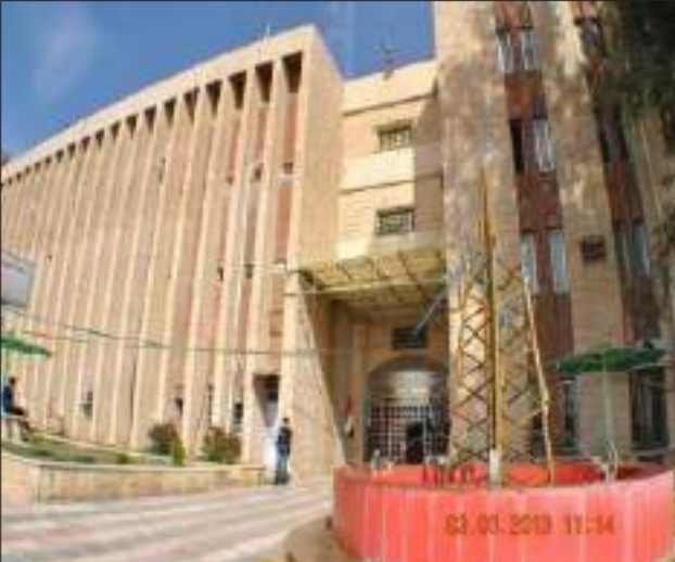
بناية قسم الهندسة الكهربائية قبيل احتلال داعش وتعرضها للقصف
